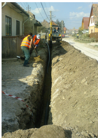
A vízvezetékek lefektetése
