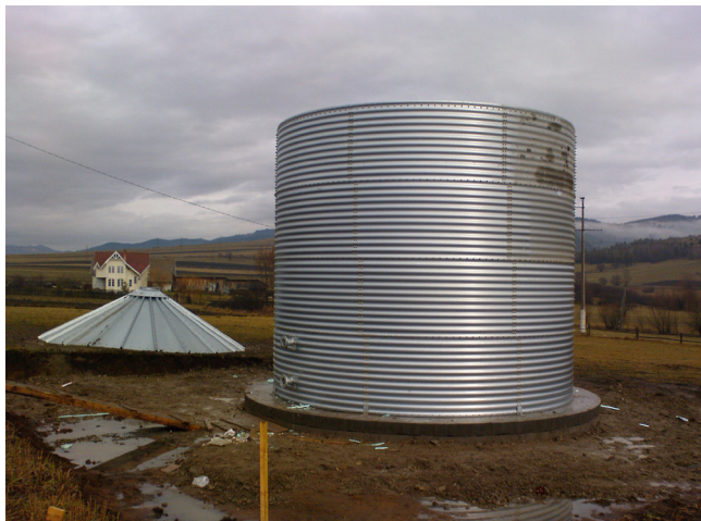
Így készült a 100 m 3 -es fémvázastartály
